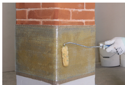
Faza 6: Impregnacija proizvodom FASSA EPOXY 200
