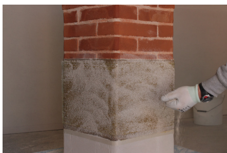
Faza 7: Postupno nanošenje pijeska
