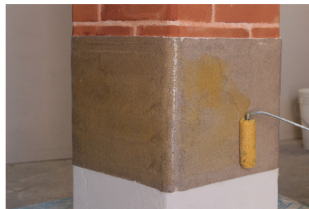
Faza 2: Nanošenje proizvoda FASSA EPOXY 200
