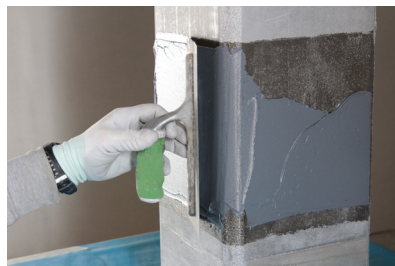
Faza 2: Ujednačavanje proizvodom FASSA EPOXY 400
