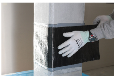
Faza 5: Stavljanje proizvoda FASSATEX CARBON UNI 300 / 301 / 600
