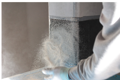
Faza 7: Postupno nanošenje pijeska
