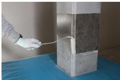
Faza 1: Tretiranje proizvodom FASSA EPOXY 100, gdje je potrebno
