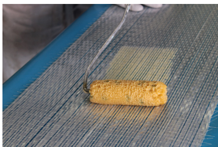
Faza 3: Predimpregnacija proizvodom FASSA EPOXY 200
