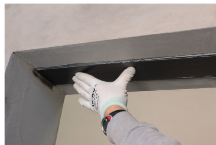
Faza 6: Stavljanje proizvoda FASSAPLATE CARBON
