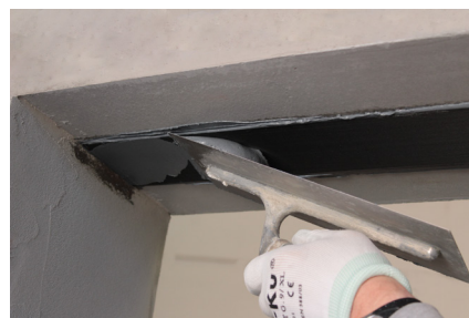
Faza 8: Nanošenje ljepila FASSA EPOXY 400 na tanku ploču
