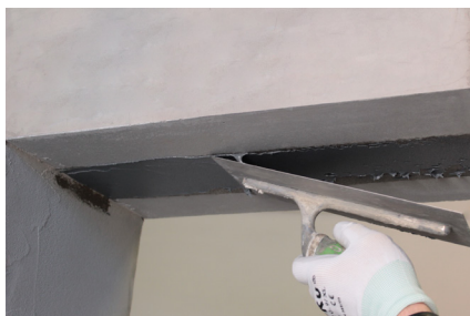
Faza 3: Ujednačavanje proizvodom FASSA EPOXY 400
