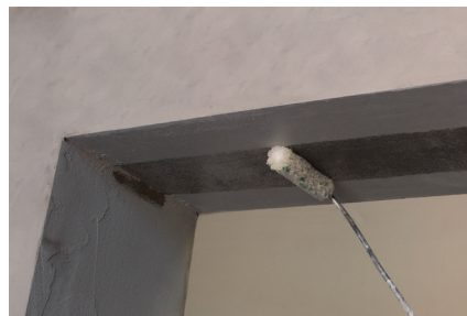
Faza 2: Tretiranje proizvodom FASSA EPOXY 100, gdje je potrebno
