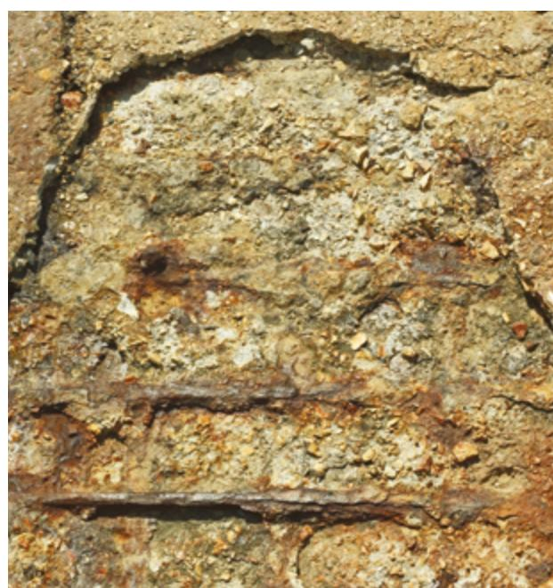
Primjer korozije uslijed napada klorida.
