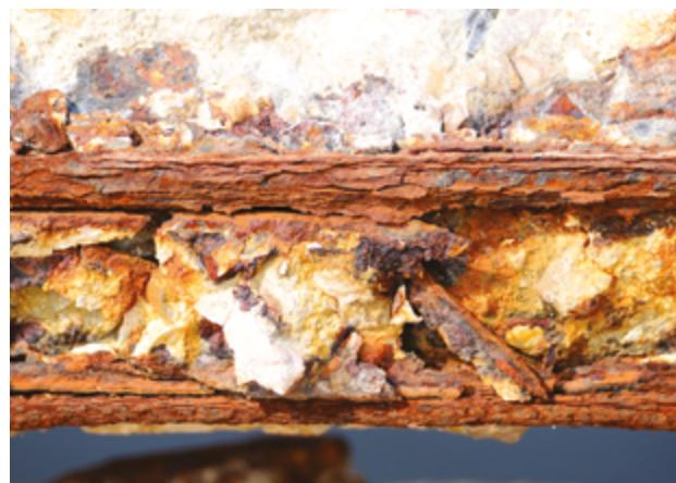
Primjer dotrajalosti betona zbog hrđanja armaturnih šipki.
