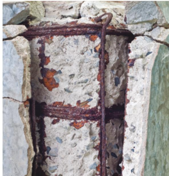
Izbacivanje betonskog pokrova zbog hrđanja armaturnih šipki.
