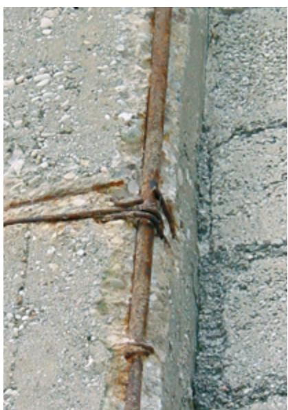
Dotrajalost betonskog pokrova u betonskom stupu.
