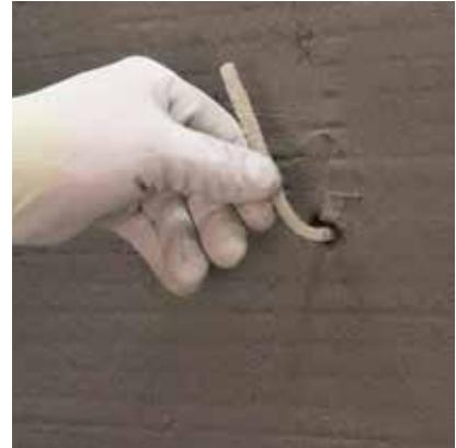
Preporučuje se ne umetati silom spojni element u rupu iznad točke kontakta savijanja armaturne mreže da biste sprječili nastanak štetnih nedostataka plošnosti same mreže.
