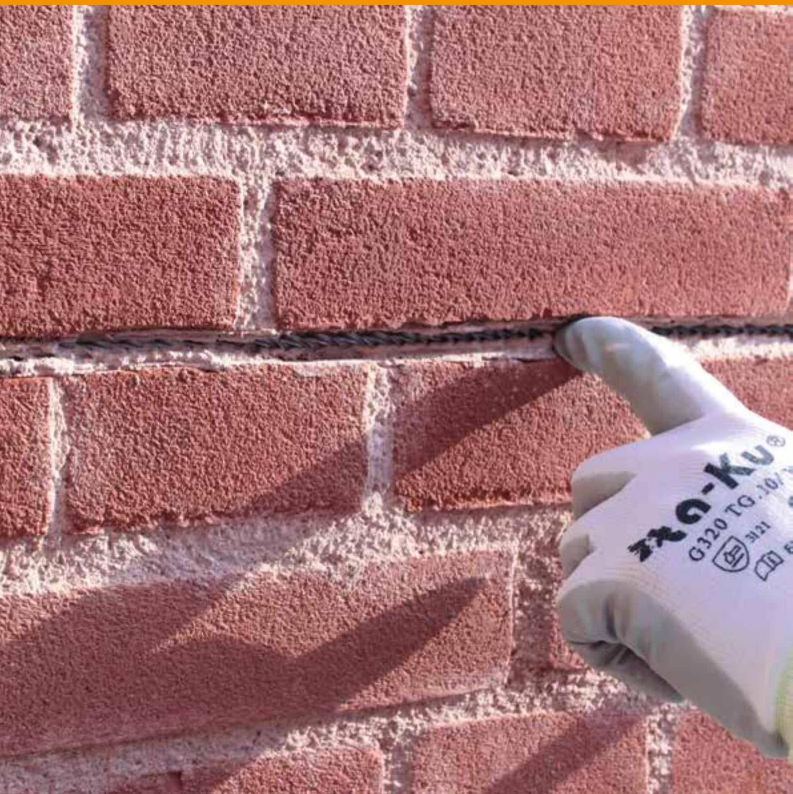
Rješenja male invazivnosti za suho spajanje odvojenih zidnih panela ili, u kombinaciji s mortovima na bazi NHL-a, za popravak i armaturu tehnikom armiranog ponovnog brtvljenja
